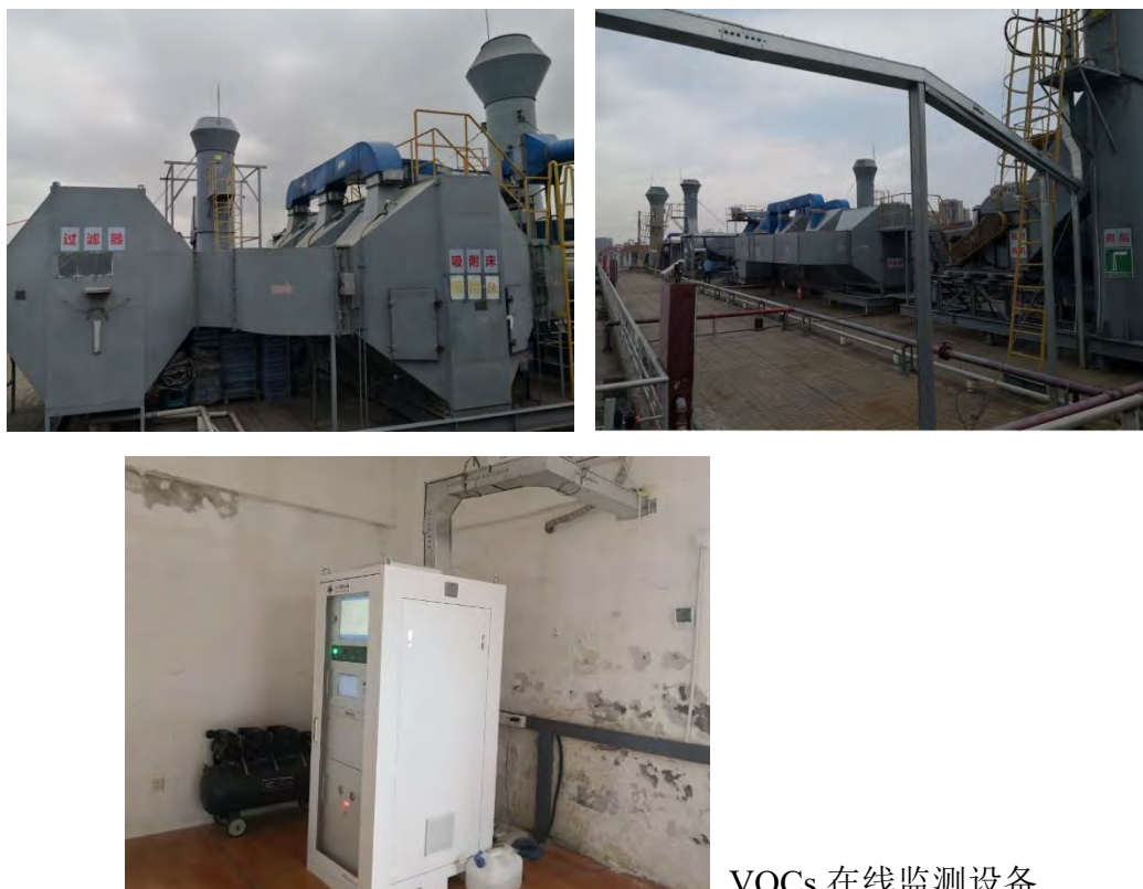
图 4.1-16 喷涂废气净化系统现状照片
