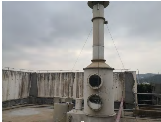
图 4.1-18 抛光粉尘处理设施现状照片
