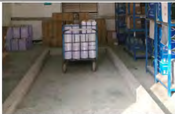
图10 危化品仓库围堰及地面防腐防渗
