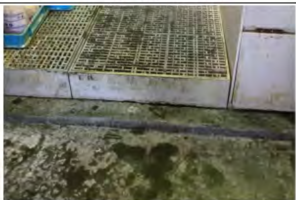
图16 电镀车间围堰及地面防腐防渗
