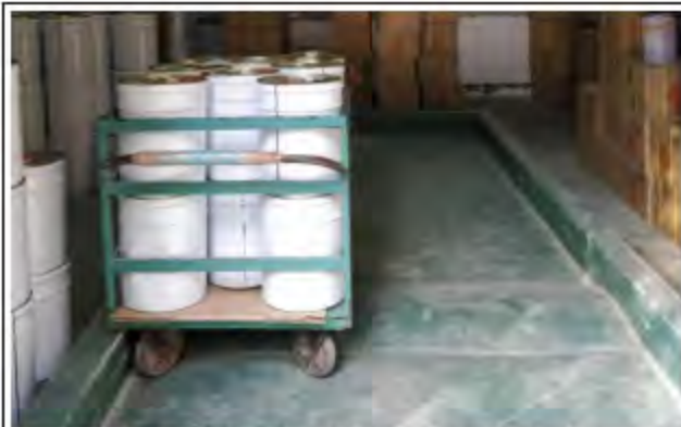
图9 危化品仓库围堰及地面防腐防渗
